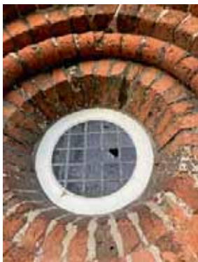
kaputte Scheiben der Oculi/Risse Deckenkonsole
